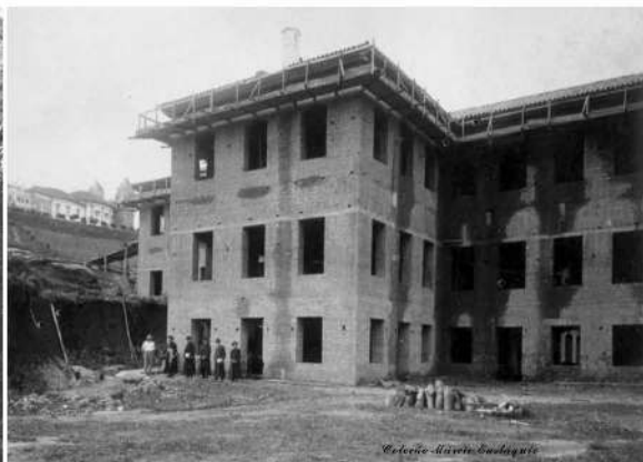
Prédio do Seminário Maior em construção
