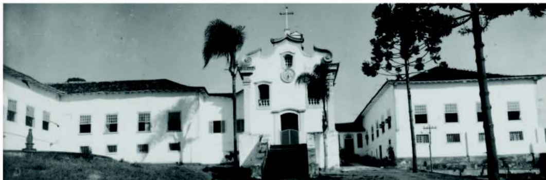
Prédio do Seminário Menor Nossa Senhora da Boa Morte
